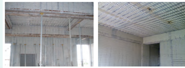
13 養護完成支撐拆除
