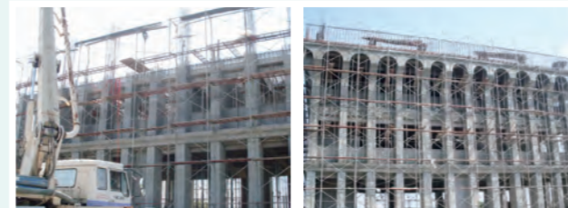
14 逐層多層RC結構施工
