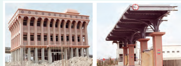
16 表面裝飾材施工
