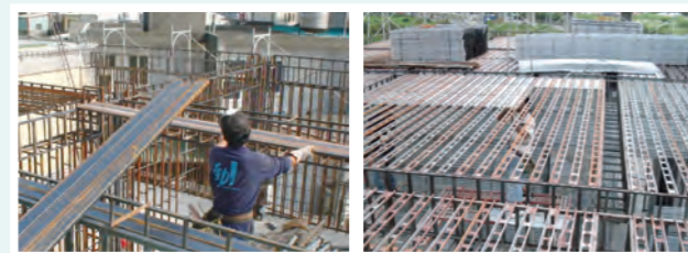
6 樓板桁架組立
