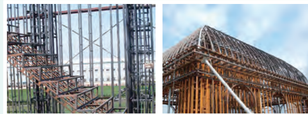
5 外牆桁架組立
