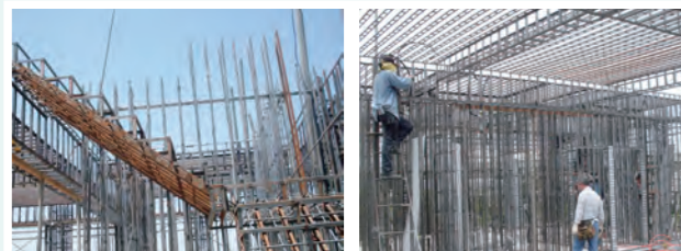
7 內隔間桁架組立
